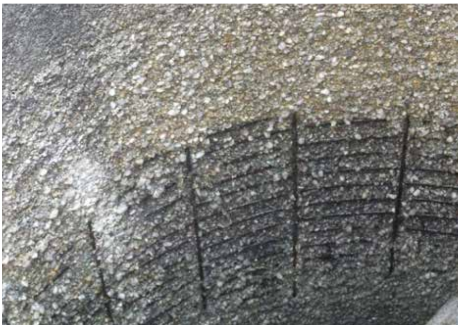
Příklad koroze betonu u čerpacích stanic.
